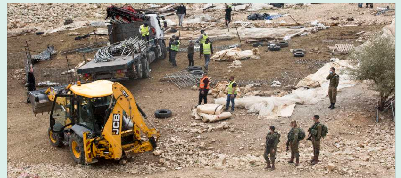
▲ Engins JCB utilisés lors de la destruction par les forces israéliennes de tentes palestiniennes et d'abris pour le bétail dans la communauté pastorale de Wadi al-Ahmar, dans la vallée centrale du Jourdain, en janvier 2021. Crédit photo : Keren Manor/Activestills
